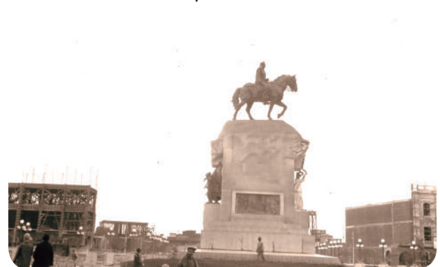
Construcción de la Plaza San Martín.
